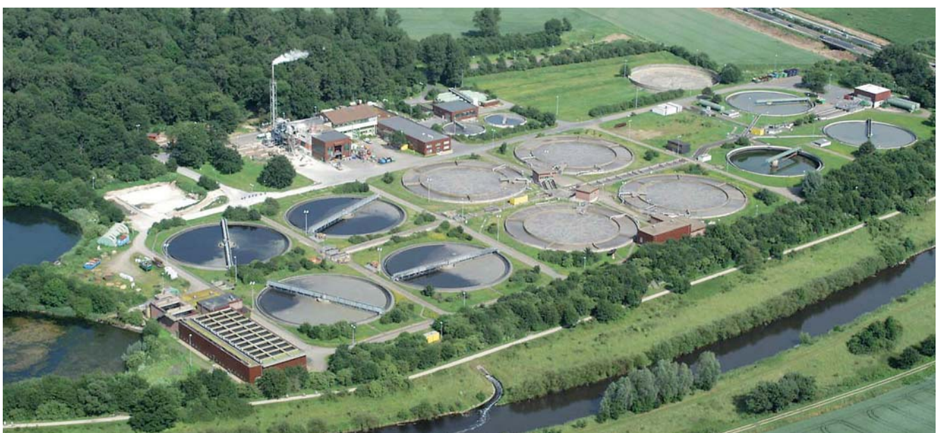
Luftbild der Kläranlage Düren
