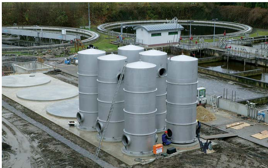
Die Kläranlage Schwerte des Ruhrverbands wird für die Erprobung von Verfahren, die Mikroverunreinigungen vermindern, umgebaut.
