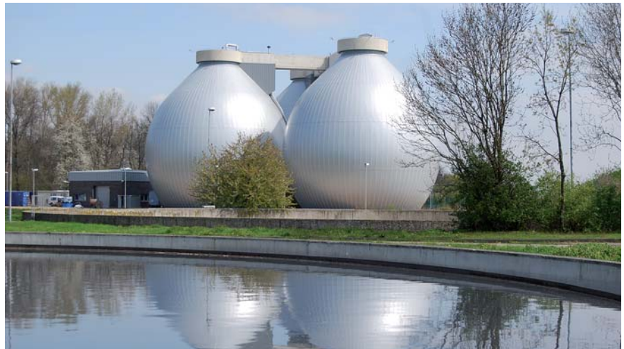
Die neuen Faultürme auf der Kläranlage Düren des WVER
