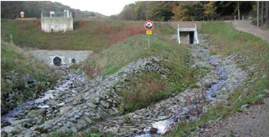
Hochwasserrückhaltebecken in Wuppertal-Ronsdorf
