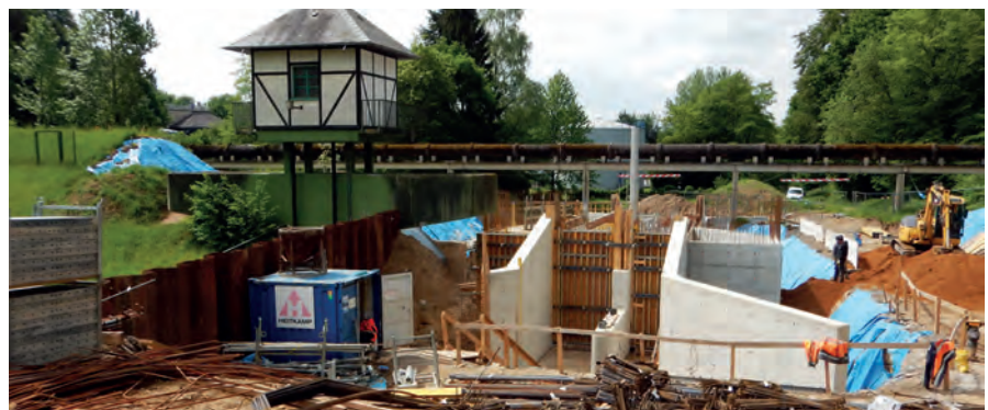
Blick in Richtung Absperrdamm, links Altanlage, rechts Kombinationsbauwerk im Bau (BRW)
