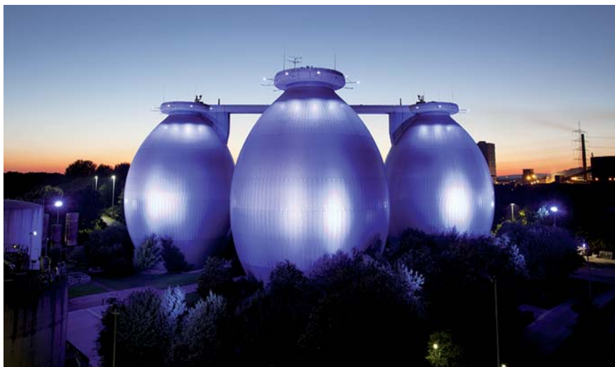
Faultürme des Emscherklärwerks in Bottrop, Quelle: Stefan Bayer
