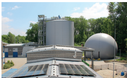
Gruppenklärwerk Kaarst-Nordkanal: Faulbehälter und Gasspeicher
