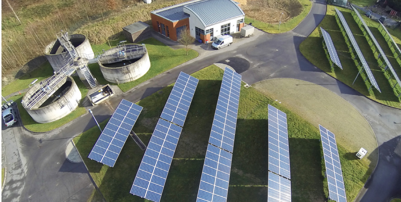
PV-Anlage der Kläranlage Essen-Kettwig (Ruhrverband)
