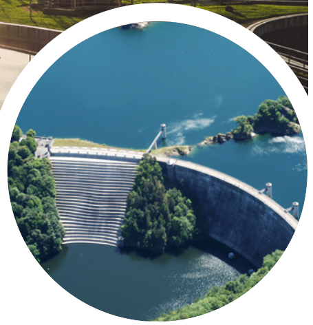
Oben: Die Kläranlage Aachen-Soers Unten: Die Urfttalsperre
