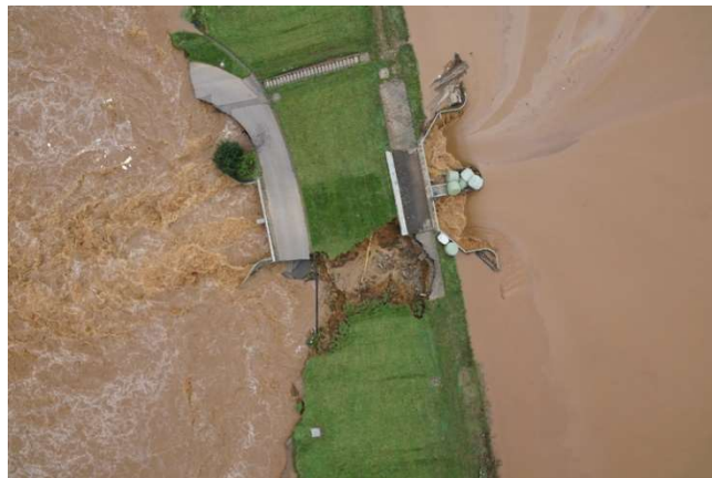
Abbildung 3: Hochwasserrückhaltebecken Horchheim am 15.07.2021 (Foto: Erftverband).
