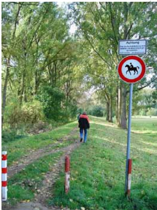
Bild 17: Verkehrssicherungsmaßnahmen an einem Hochwasserschutzdeich mit unbefestigter Deichkrone, an der Mündung der Sieg in den Rhein (Fotos: E. STÄDTLER)
