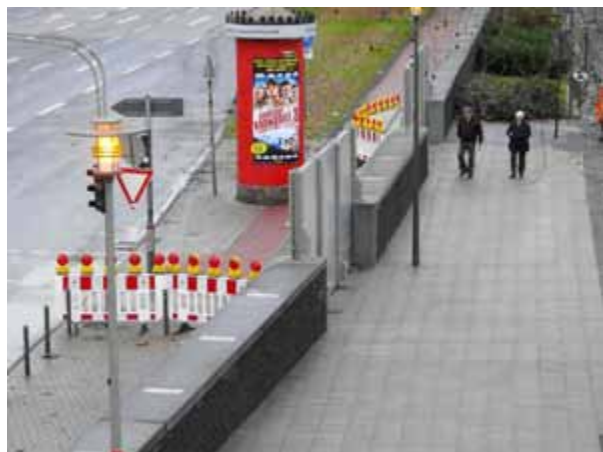
Bild 20: Sperrung für Fußgänger und Schutz der mobilen Elemente im Bereich der aufgebauten mobilen Hochwasserschutz-elemente am Rhein in Köln, Januar 2011 (Foto: E. STÄDTLER)
