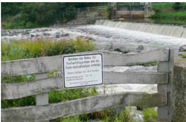
Bild 55: Warn- und Hinweisschild einer gefährlichen Betriebsstelle (Foto: E. STÄDTLER)
