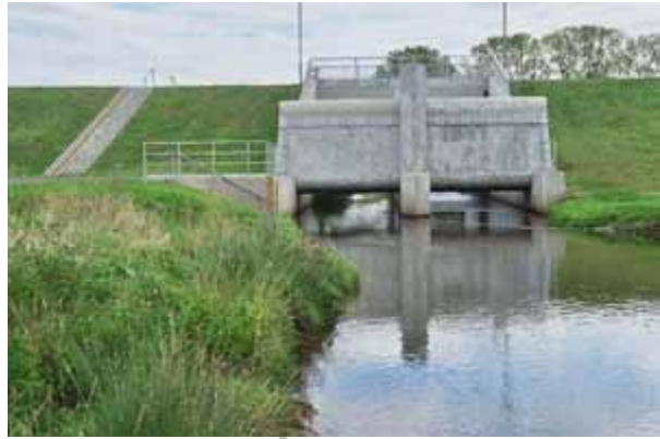
Bild 21: Sicherungsmaßnahmen am Absperrbauwerk mit Damm – ohne Umzäunung (Foto: E. STÄDTLER)
