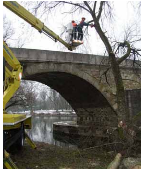
Bild 10: Wahrnehmung der Verkehrssicherungspflicht am Gewässer im Bereich einer Brücke. Rückschnitt von Hand vom Korb aus (Foto: G. KOLLER)
