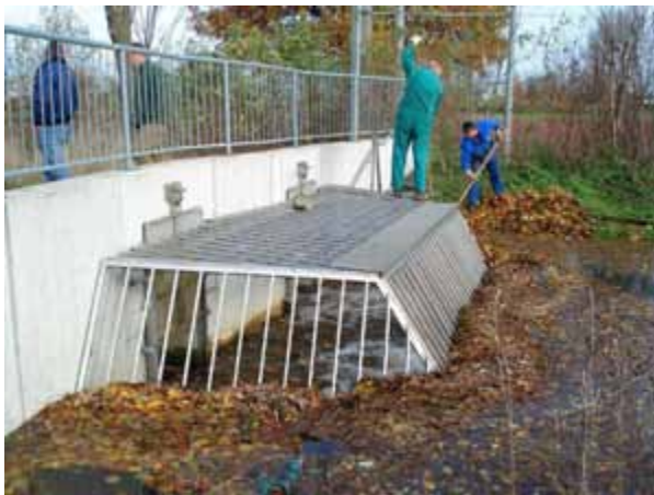
Bild 40: Einlaufrechen von Bild 39 bei Hochwasser (Foto: E. STÄDTLER)
