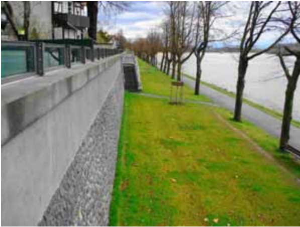
Bild 18: Hochwasserschutzwände in Köln, Porz Westhoven für ein BHW 200 mit Glasaufsatz und Treppenaufgang und -abgang. Rechts im Bild der uferbegleitende Weg für Radfahrer und Wanderer (Foto: E. STÄDTLER)
