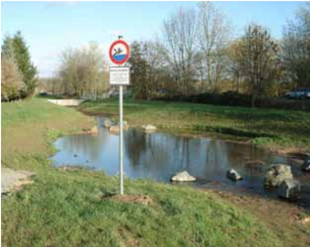
Bild 46: Sandfang als Erdbecken mit abgeflachten Böschungen am Birgeler Bach in Düren mit Hinweisschild (Fotos: E. STÄDTLER)
