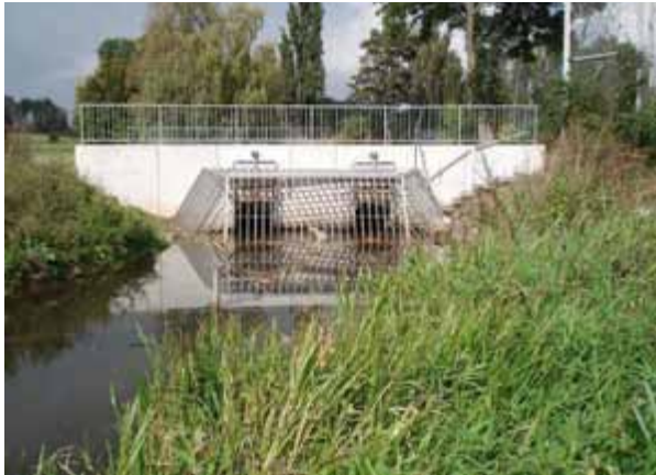
Bild 39: Dükereinlauf mit Sicherungsmaßnahmen in Linnich/Rur bei Normalwasserführung (Foto: E. STÄDTLER)
