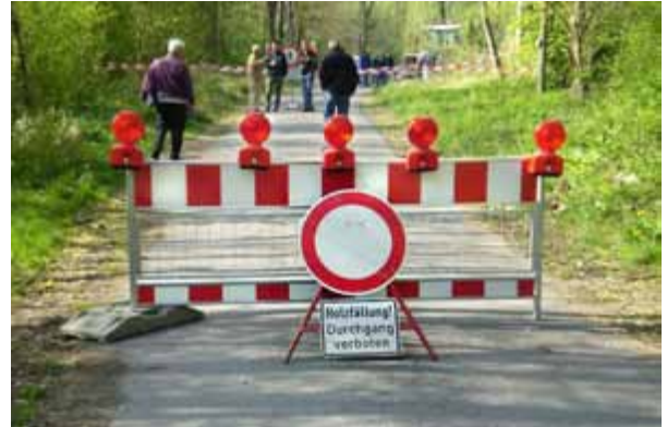
Bild 36a: Sicherungsmaßnahmen bei Holzfällarbeiten – äußere Absperrung (Quelle: © BAYERISCHES LANDESAMT FÜR UMWELT)
