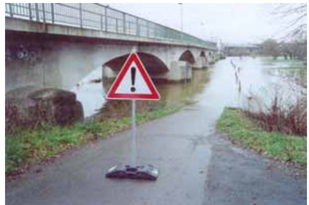
Bild 50: Einfache Sicherungsmaßnahme bei Hochwasser für einen Rad- und Wanderweg durch die Gewässeraue (Foto: E. STÄDTLER)
