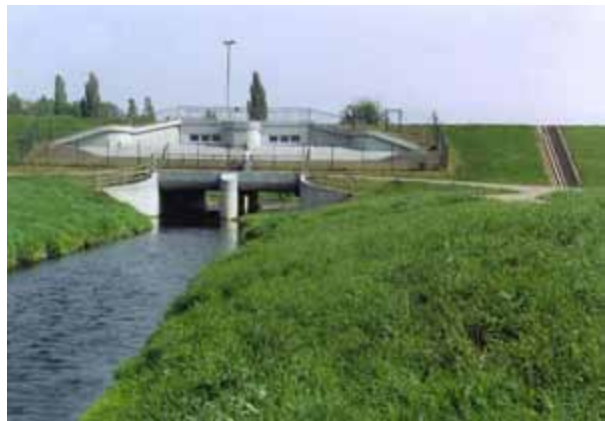
Bild 22: Sicherungsmaßnahmen am Absperrbauwerk und Damm Hochwasserrückhaltebecken Horchheim/Erft (Foto: E. STÄDTLER)
