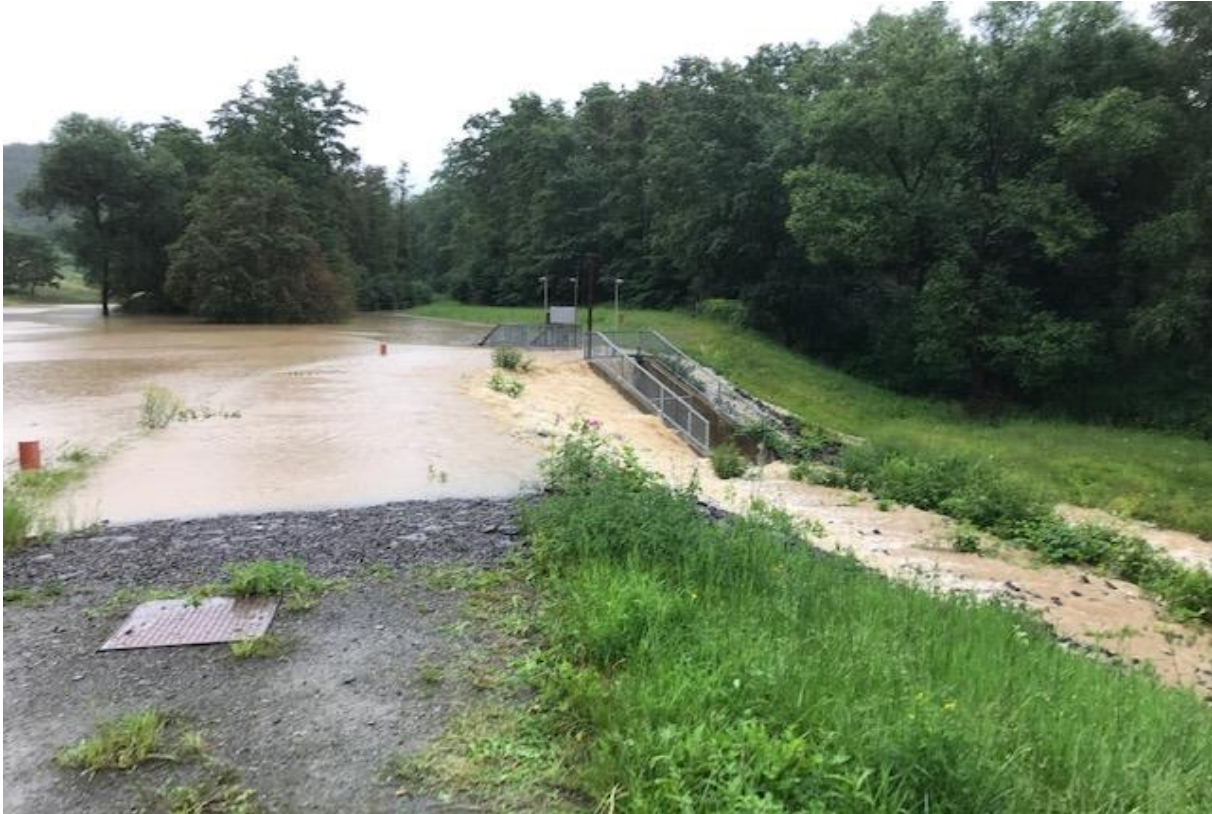
Abb. 17: Überlastung des Hochwasserrückhaltbeckens Overath-Steinenbrück in der Talstrasse (Aggerverband, 2021 38 )
