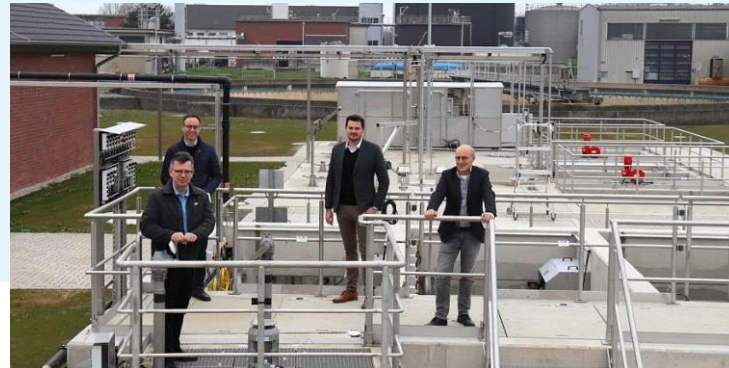
Kläranlage Rheda-Wiedenbrück – Inbetriebnahme Ozonanlage 2021
