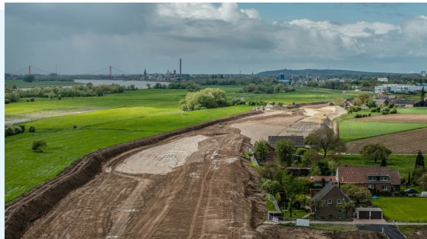
Deichsanierung zw. Dornick und Emmerich. Rhein im Hintergrund. (Foto: Markus van Offern)
