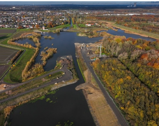
Hochwasserrückhaltebecken Emscher-Auen an der Stadtgrenze Dortmund/ Castrop-Rauxel. (Foto: Rupert Oberhäuser/ EGLV)
