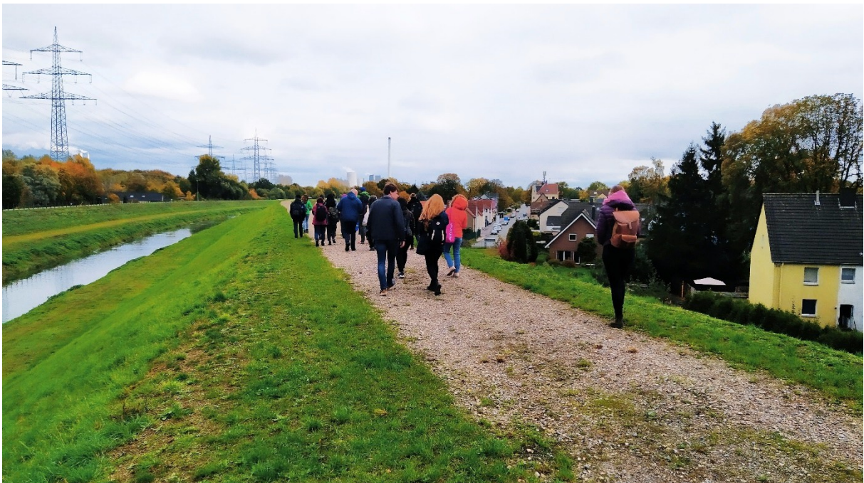
Abbildung 2: Emscher-Deich in Herne, Ausbaugrad: HQ200 (Foto: Georg Johann)
