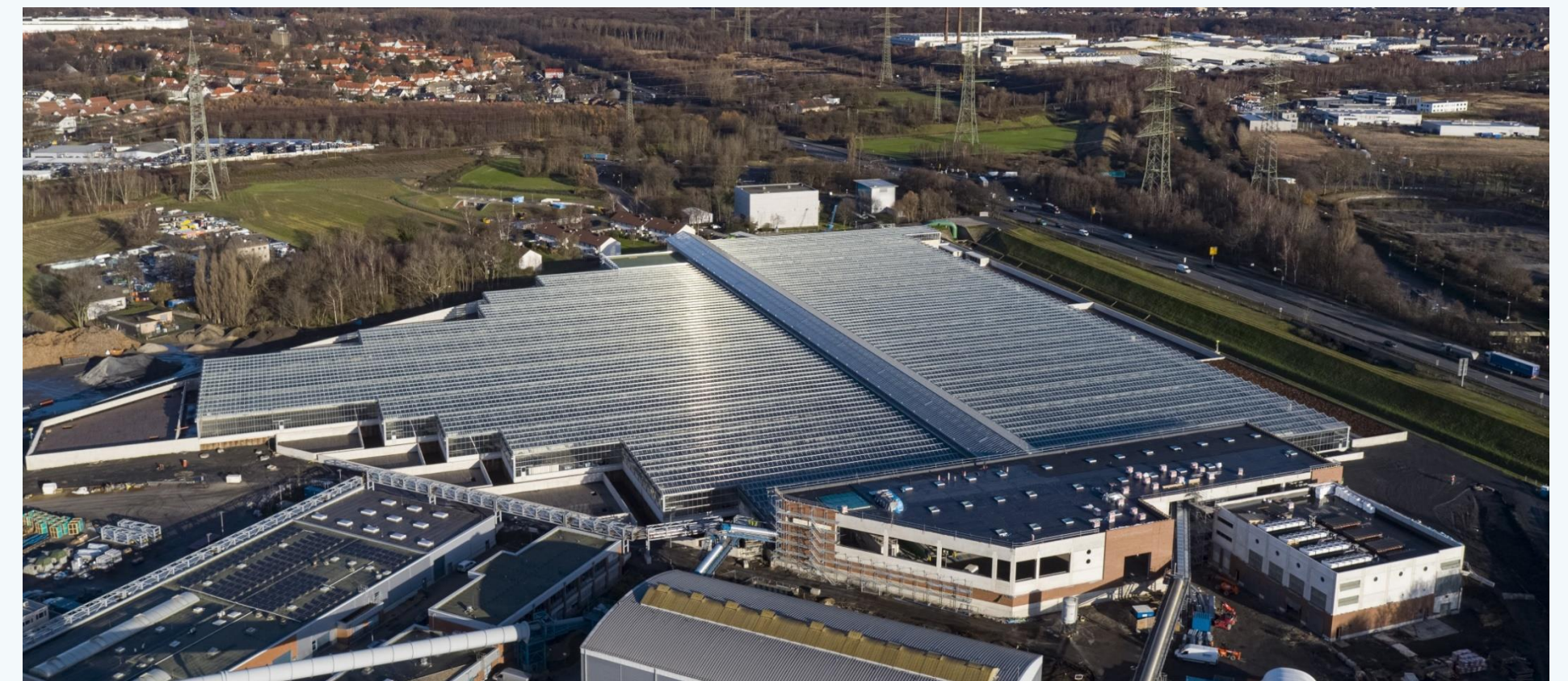
Oben: Ruhrverband Photovoltaikanlage; © Ruhrverband Unten: Solarthermische Klärschlamm-trocknung auf der Kläranlage Bottrop; © Jörg Saborowski EGLV
