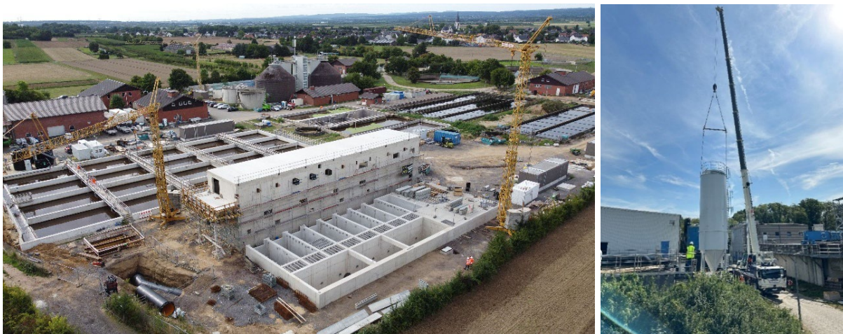
Abbildung 3: Bau der Membranbelebungsanlage mit Pulveraktivkohledosierung auf der Kläranlage Rheinbach Flerzheim (links) und Aufbau des Pulveraktivkohlesilos auf der Kläranlage Kaarst-Nordkanal (rechts) des Erftverbandes (Fotos: Erftverband)
