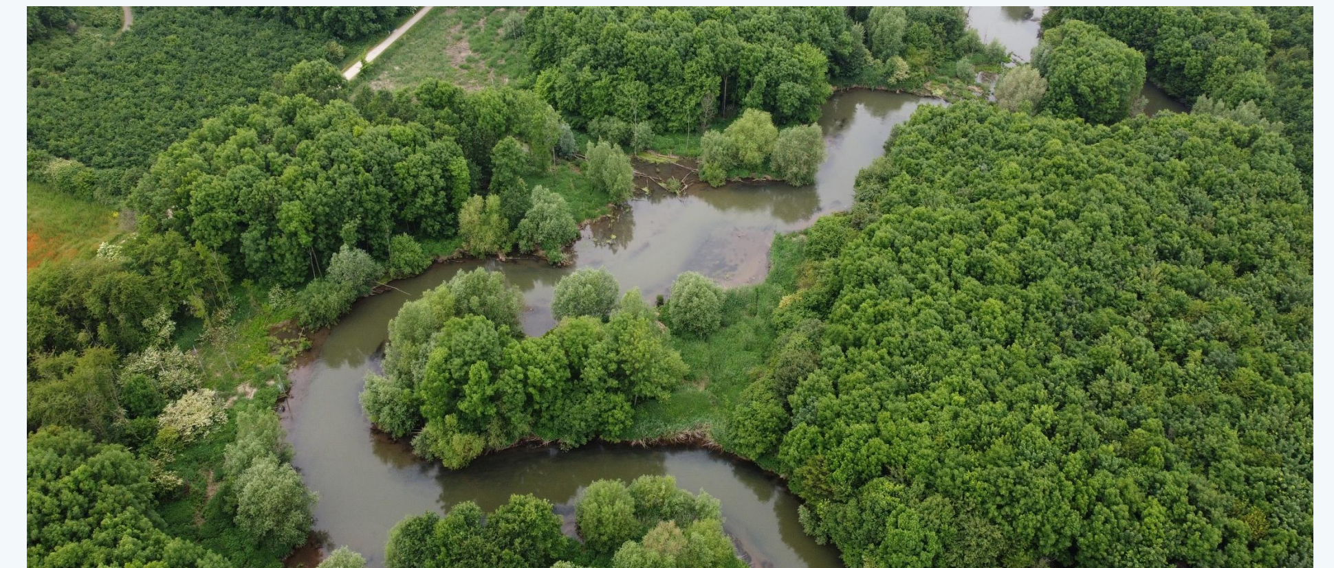
Oben: Renaturierung Viersen Fritzbruch Betriebsstelle Suechteln © Martin Hochbruck Unten: Erftumbau Bergheim Kanten Vogelwäldchen © Erftverband
